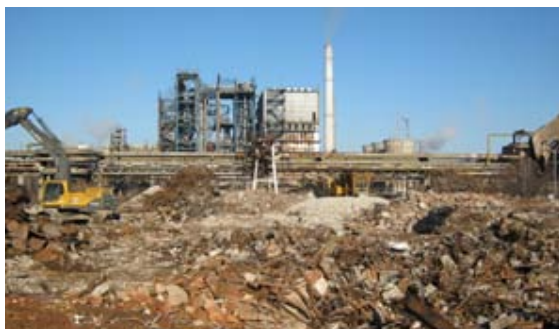
Lucrări de dezafectare – Doljchim, 2011
