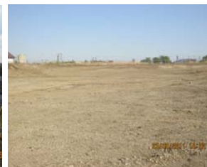
După - „Gara Brazi” - Batal de șlam petrolier remediat, 23 Septembrie 2011
