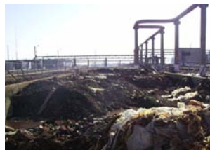
Înainte – Depozit de acrilonitril, Februarie 2011
