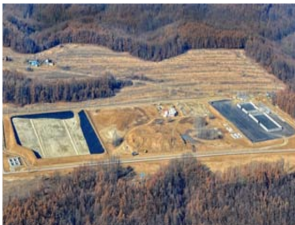
Lucrări de construcție la stația de bioremediere și groapa de gunoi – Zona de producție de la Țicleni, 2011
